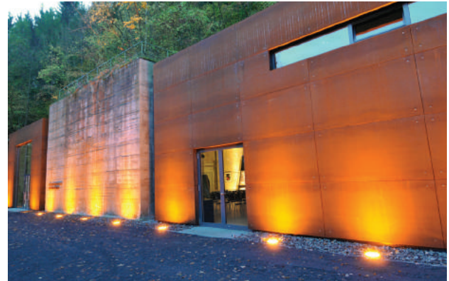
Abb. 2: „Außenansicht der Dokumentationsstätte Regierungsbunker“ (Quelle: www.regbu.de , Fotograf: Kajo Meyer)
